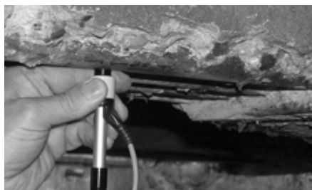
Obr. 7 Měření tvrdosti výztuže rázovou jednotkou „D“
