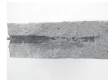
Obr. 14 Nezkarbonatovaný beton (růžový) a korozní produkty zokoušení austenitické korozivzdorné oceli v betonu se 3 hm.% Cl-/cem
