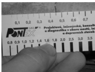
měření šířky trhlin
