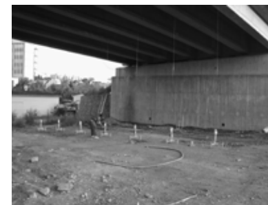
ověření průhybu konstrukce
