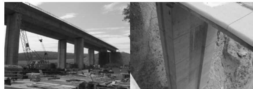
Obrázok 2 Most nad potokom Malá Svinka (vľavo) a mostný pilier (vpravo)
